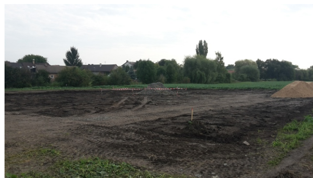
Stavba čistírny odpadních vod
